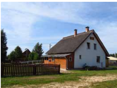
Das renovierte Gemeinschaftshaus
